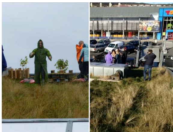
Figure 2.4: Toiture verte en permaculture sur le Centre Commercial Alna, Oslo
