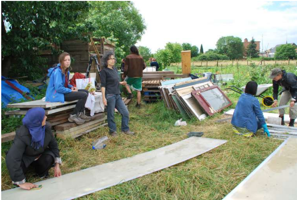
Portes et châssis de récup' pour construire un abri fermé
