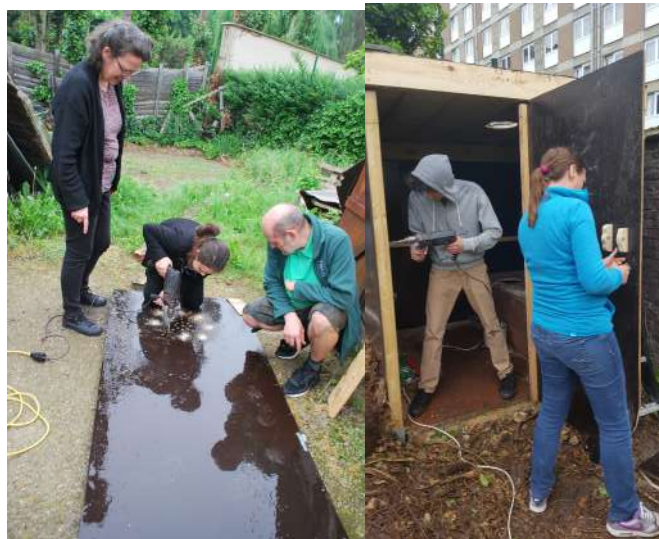
Pendant ce temps, d'autres ont décoré la porte avec un motif à petit trous pour laisser passer la lumière, d'autres encore ont restauré les escaliers menant à la toilette ou se sont occupé de la poignée de porte et du verrou.
