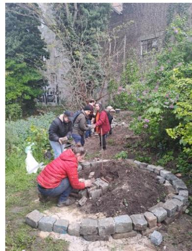
Les pavés (de récup) sont ensuite posés en quinconce, en veillant à l'horizontalité de chaque lit pour une bonne stabilité de la spirale. Peu à peu la spirale est remplie d'un mélange de terre de sable et de briquillons. Les murs montent et les nichoirs sont insérés dans les murs.
