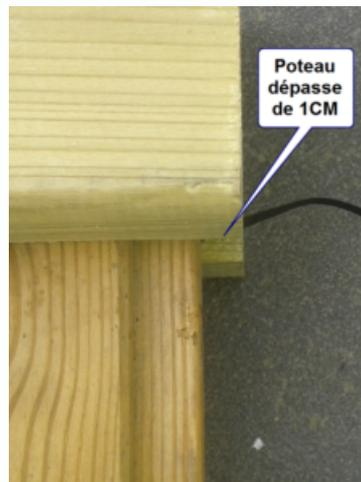
La hauteur des poteaux dépend de la hauteur du bac. Faire couper sur mesure les poteaux de coin à une hauteur de 1 cm supérieure à la hauteur totale des planches. Ceci permet au bas de la planche de ne pas être en contact avec le sol et prévient ainsi la pourriture de s'installer. Les planches rainurées s'emboîtent l'une dans l'autre, ce qui solidifie le bac dans sa longueur. La partie fine est vers le bas du bac.
