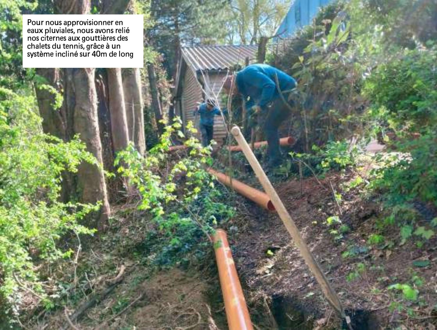
Une surface totale de toitures de 64 m<sup>2</sup> alimente nos citernes en eaux pluviales. Avec une telle surface de captage nos citernes se remplissent rapidement.
