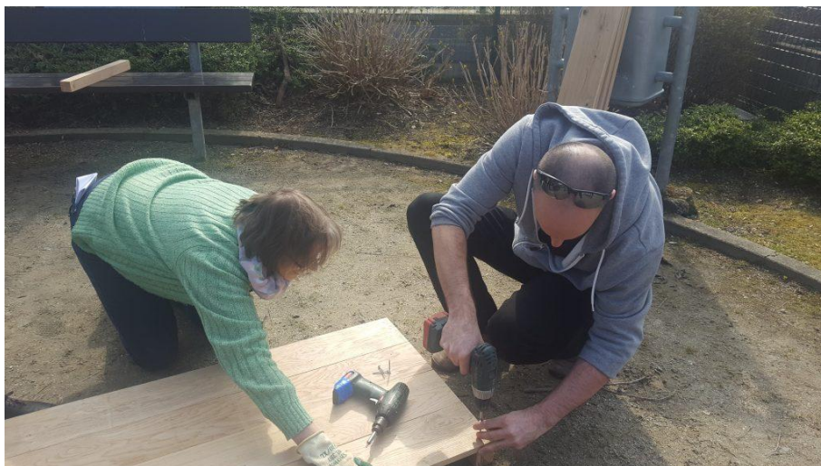
Daarna de zijwanden schroeven
